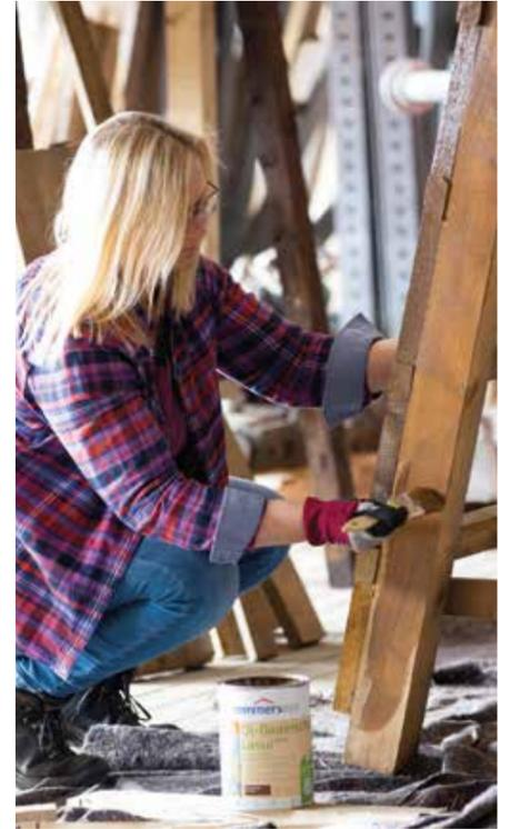
Im Anschluss an die Grundierung wurde die Öl-Dauerschutz-Lasur [eco] auf das Holz aufgebracht.
